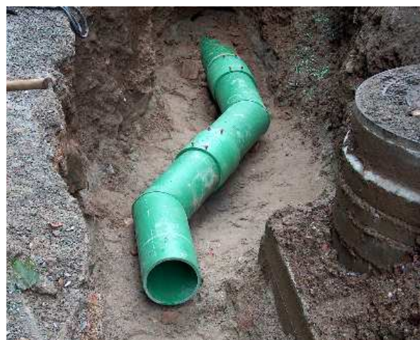
Bild 3: Einbau von Rohrbögen mit Heizwendel-Schweißmuffen
