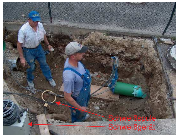
Bild 5: Rohreinbaugrube mit Schweißspule und Schweißgerät
