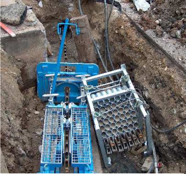
Bild 4: Maschinenbaugrube mit Berstanlage
