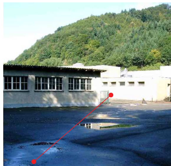
Bild 1: Betriebsgelände Fa. Gütermann AG mit eingezeichnetem Verlauf eines Abschnitts des zu sanierenden Kanals
