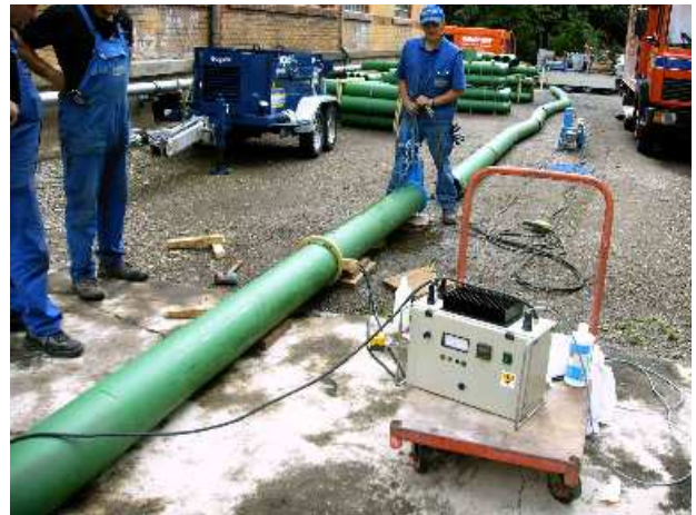
Bild 2: Erstellung der Multi-Raster-Schweißverbindung für den Rohrabschnitt in offener Bauweise
