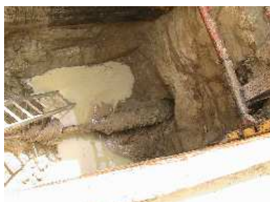
Ankunft des Rohrstranges in der Zielbaugrube in Augsburg
