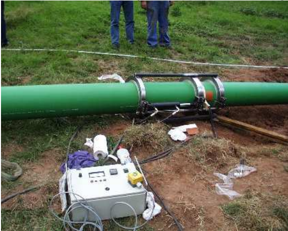
Anschweißen eines Rohrmoduls an den Neurohrstrang in Sylzhain
