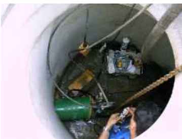
Einbau der Rohre aus dem Schacht in Bautzen
