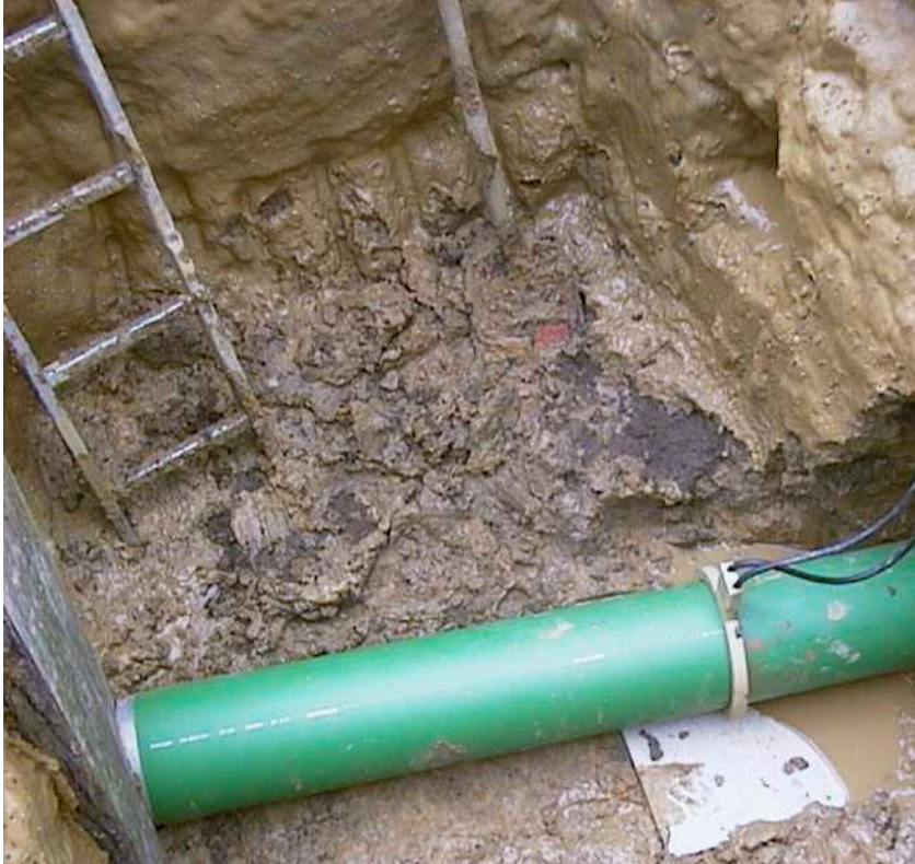
Bild 4: induktives verschweißen der Rohrmodule
