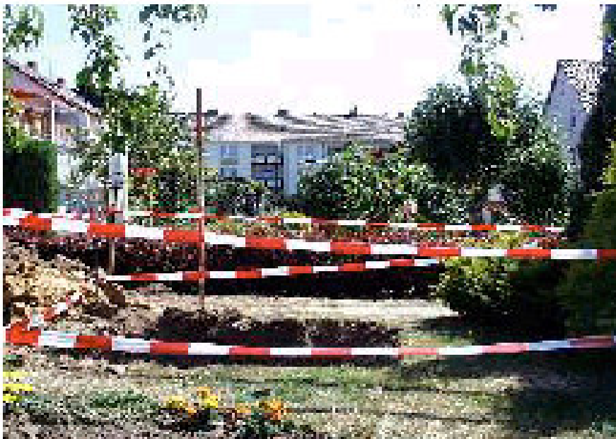
Bild 3: Baugrube unter beengten Platzverhältnissen
