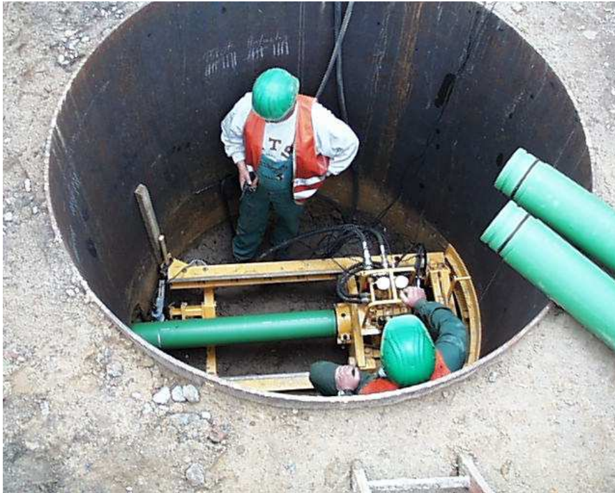
Bild 1: Einschleiben der PP-HM Vortriebsrohre in der Startbaugrube
