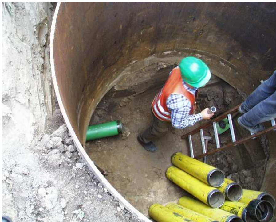
Bild 2: Ankunft der PP-HM Rohre in der Zielbaugrube
