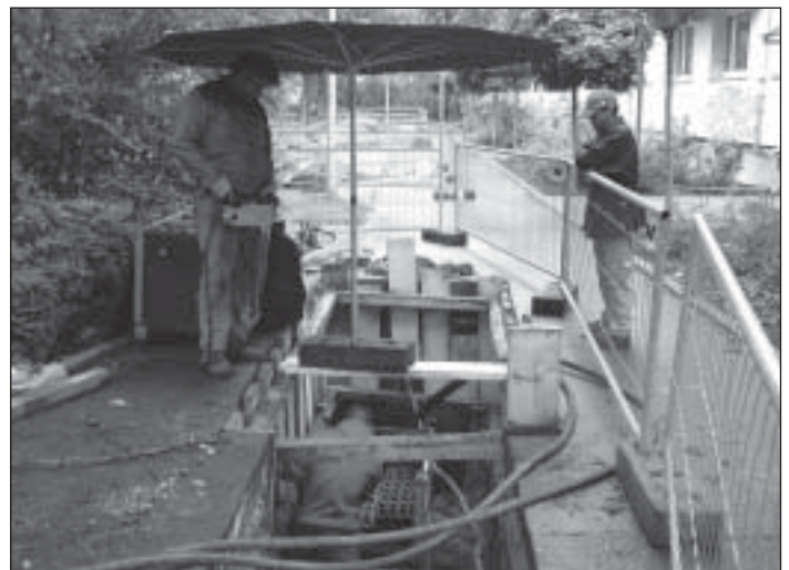
Abbildung 2: Baugrube mit eingebauter Berstlafette
