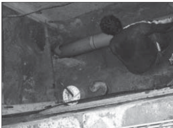
Abbildung 3: Verbinden der Rohrmodule in einer Baugruben
