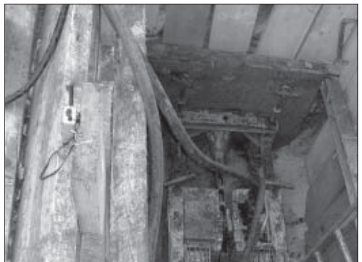
Abbildung 4: Ankunft der Aufweitung in der Maschinenbaugrube
