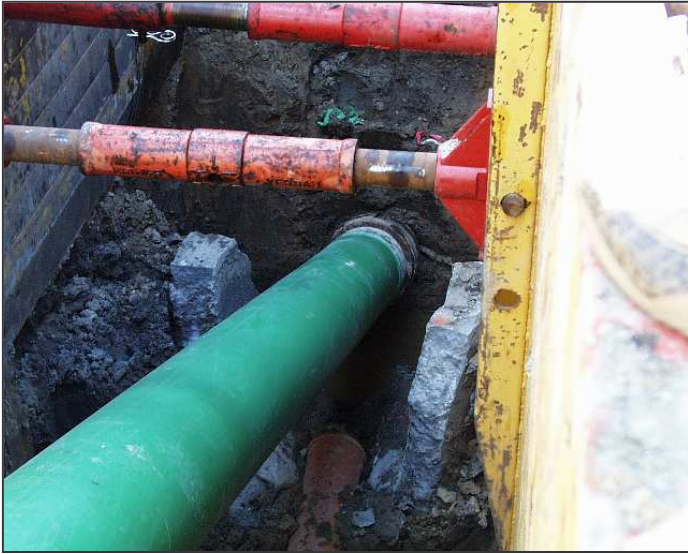
Bild 1: Einzug der Aufweitung in der Startbaugrube
