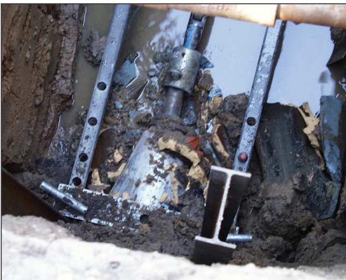
Bild 3: Ankunft der Aufweitung in der Zielbaugrube
