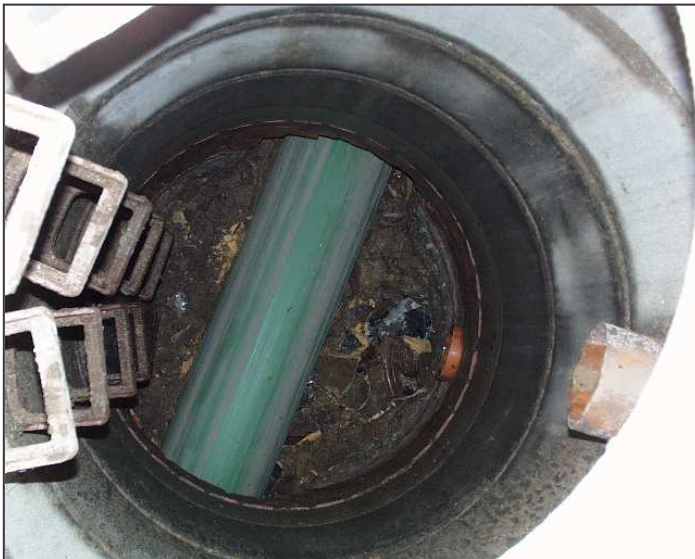
Bild 2: Durchfahren des Zwischenschachtes
